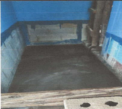
Foto 6: Colocando torta de piso para nivelar con el patio de salida
