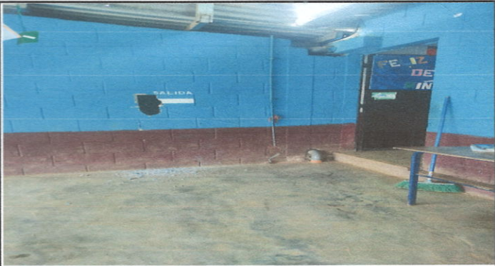
Foto1: Rompiendo pared para una puerta de entrada
