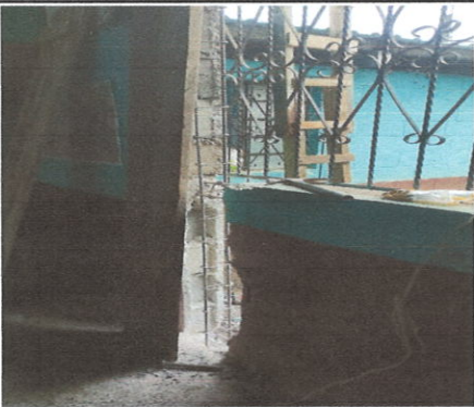
Foto 4: habriendo y colocando columna para puerta de salida del aula de preprimaria
